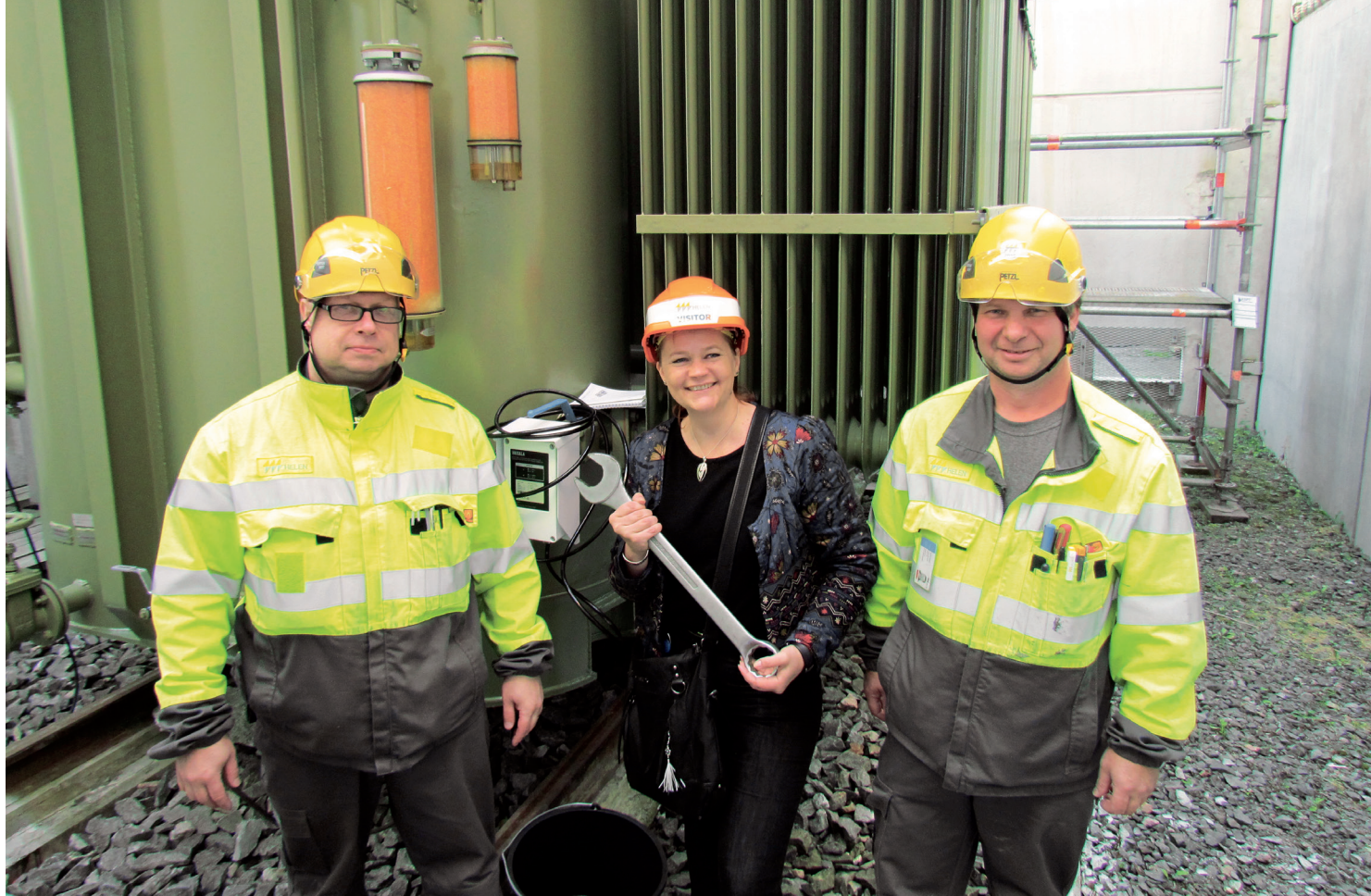
Vuosaaren voimalaitoksella uusi kunnonvalvontalaite asennettiin muun muassa laitoksen viitosmuuntajaan, joka on teholtaan 200 MVA.
