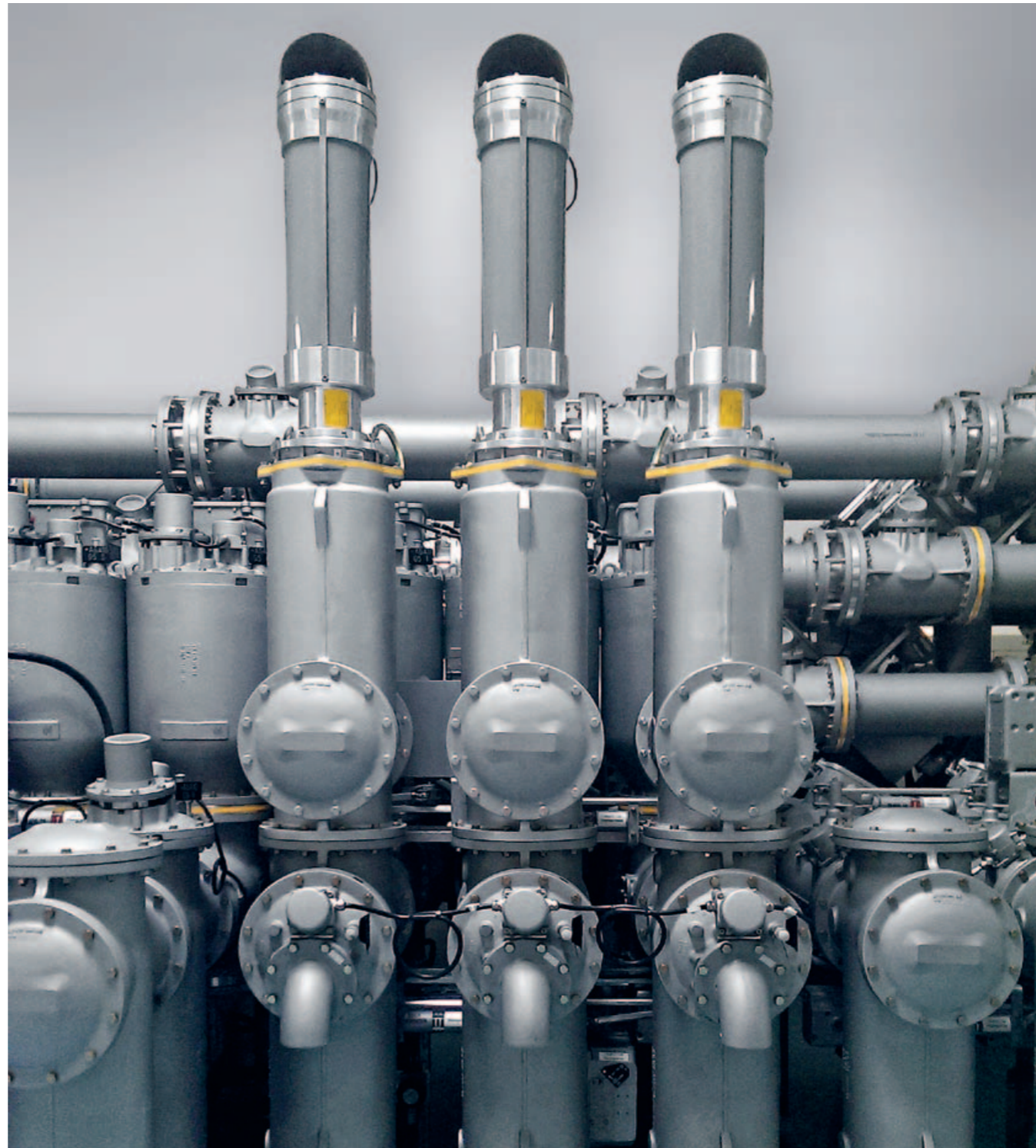
Kustannustehokas jälkiasennusratkaisu Niedergösgenin sähköasemalla: GIS-järjestelmävalmistajan vakiopäätetekelo Pfistererin HV-CONNEX-vastakkeeseen ja koon 4 HV-CONNEX-ylijännitesuojaan yhdistettynä yksivaihekytkimen sekä voimansiirron ja jakelun kytkinlaitteen laajentamiseen
