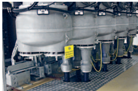
Käytössä koko Klusin sähköasemassa: pistokeliitäntäisten CONNEX-osiä ansiosta GIS on kosketusturvallinen kaikissa tilanteissa
