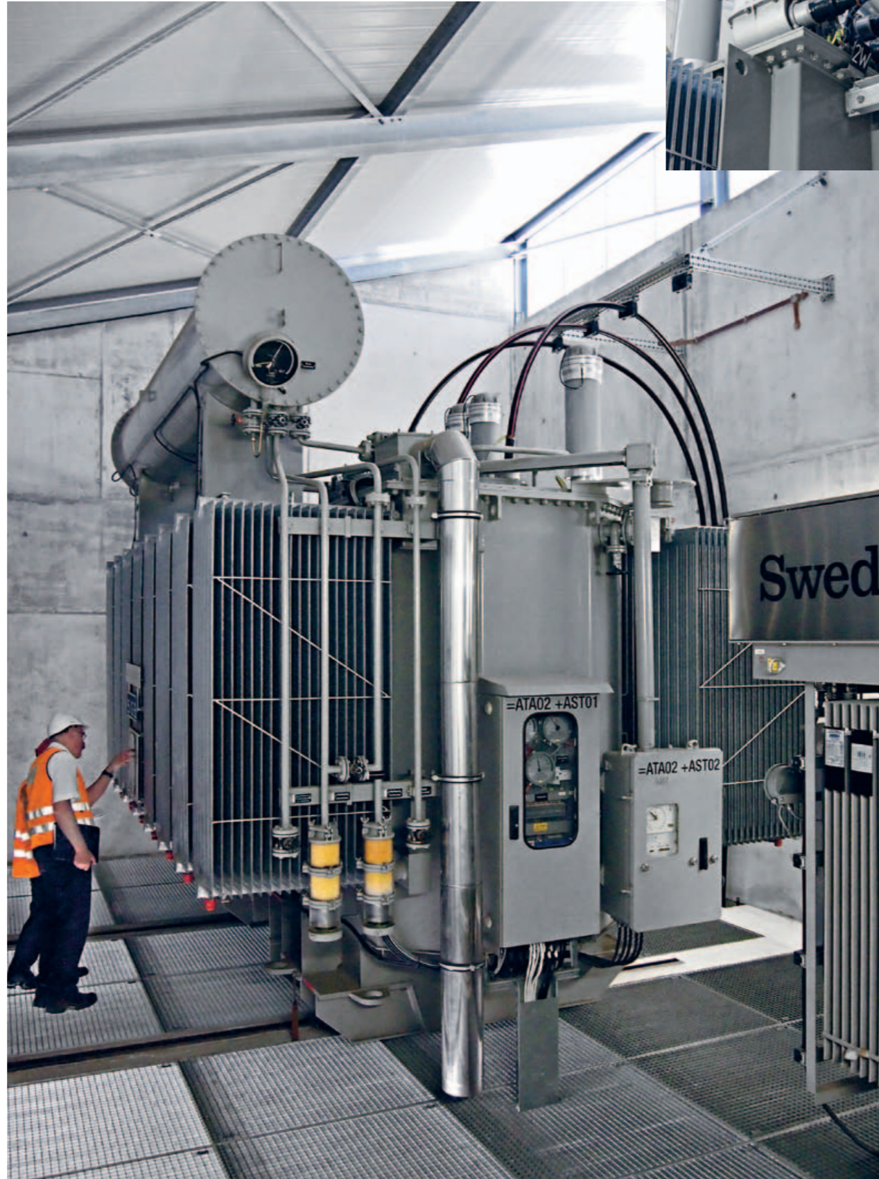
Turvallinen ja helppo huoltaa: CONNEXin ansiosta Klusin sähköaseman tehomuuntajat ovat täysin kosketusturvallisia
