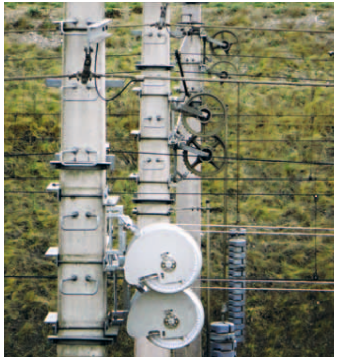
TENSOREX C+:n testiasennus ÖBB:n järjestelmään: patentoitu PFISTERER:in ratkaisu (etuvasemmalla) on huomattavasti kapeampi ja vähemmän huomiota herättävä perinteisiin kiristyspyöriin (takana oikealla) verrattuna.
